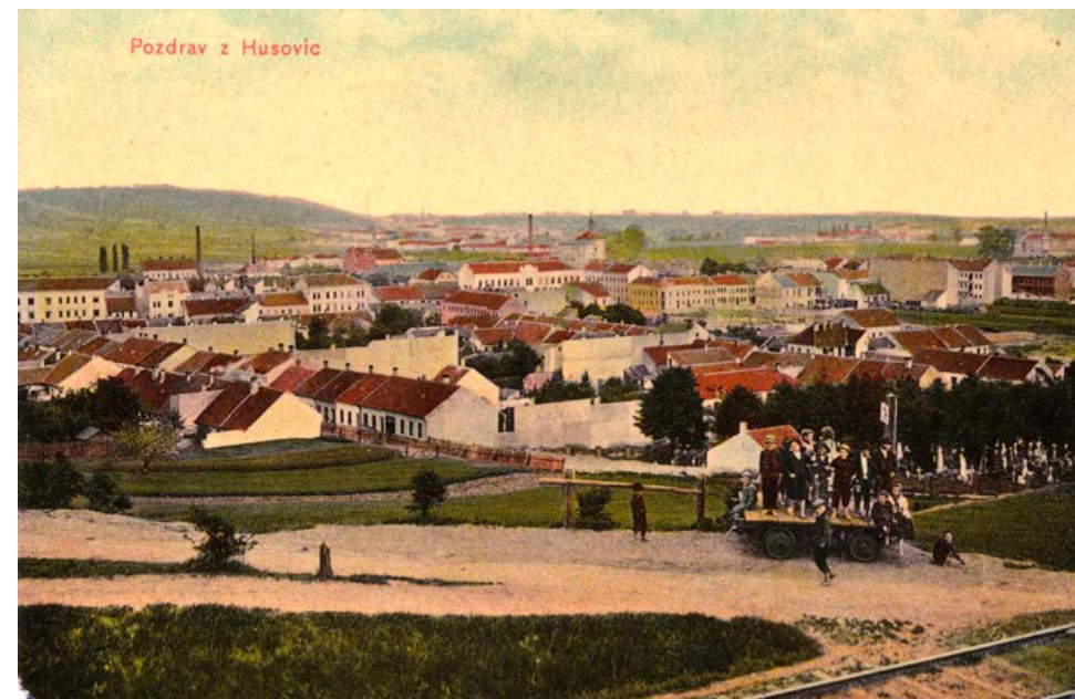
Nově budované centrum Husovic ještě bez dominanty kostela, již však s novostavbou základní školy. Vpravo lze rozeznat staveniště budoucího chrámu. Záběr z roku 1907 je pořízen z místa u bývalé železniční tratě „Tišnovky“ nad zrušeným husovickým hřbitovem (dnes park Marie Restituty)
