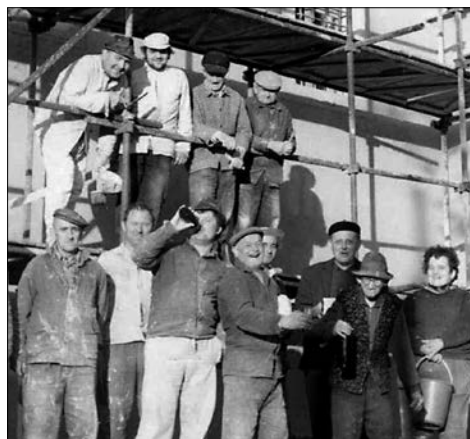
Opravy v Hrádku u Znojma, o. Krátký 3. zprava
